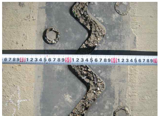
신축이음 이동량 측정
